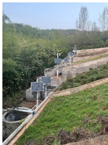
图 4-3 河南南阳南水北调渠首水土保持科技示范园
