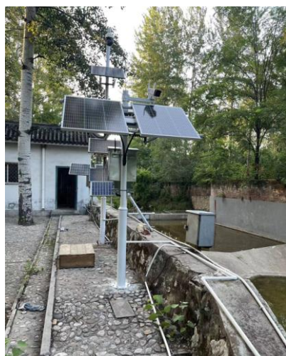
图 4-4 河北易县崇陵水土保持科技示范园
