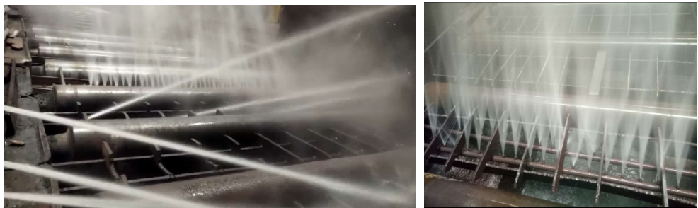
图 7 板材矫直机除磷装置安装应用
