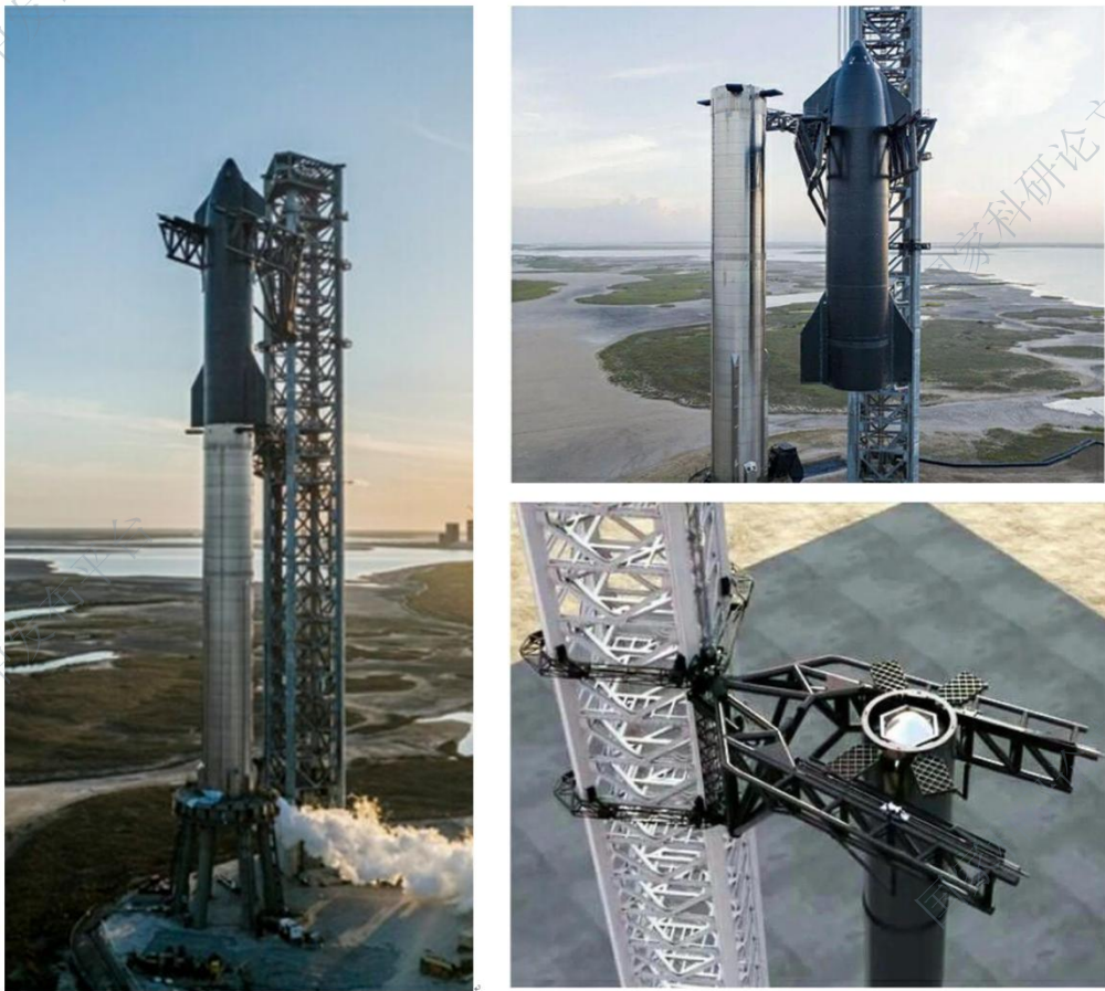
图 14 发射台和发射塔架机械捕获示意图 [14]
